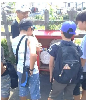
消火栓ホース格納箱の内部を点検
