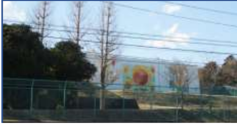
市内の第一配水場の外観
