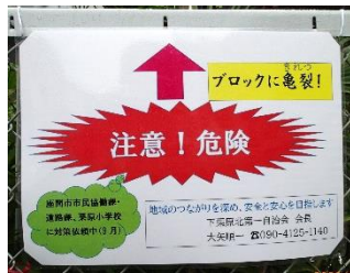
注意看板を設置
