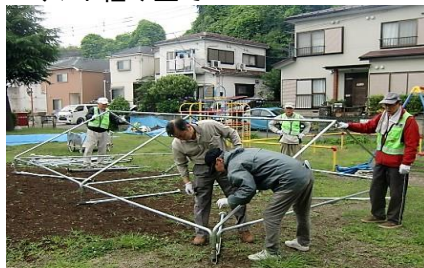
・テント組み立て
