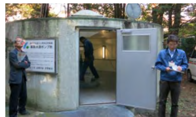
栗原水源ポンプ所
