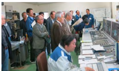
四ツ谷配水管理所2F管理センター
