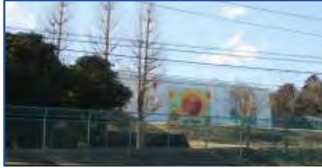
市内の第一配水場の外観
