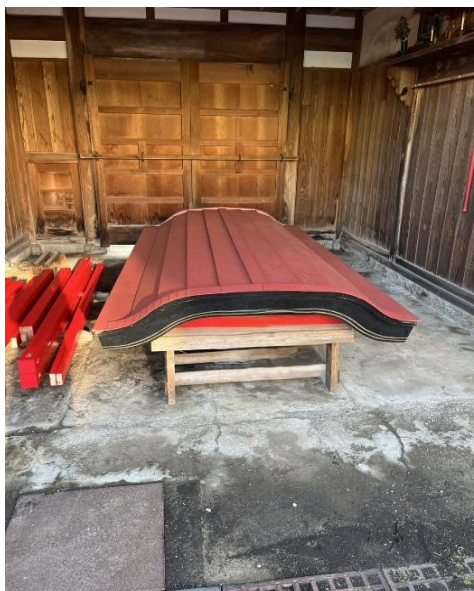
ガリバリューム鋼板完成屋根
